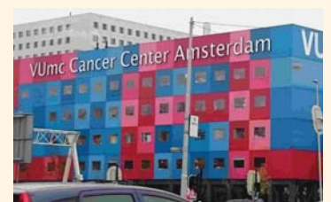
Provisorisch nur aus Containern zusammengebaut, aber sehr effektiv: Das Krebs-Forschungszentrum der Universität Amsterdam
